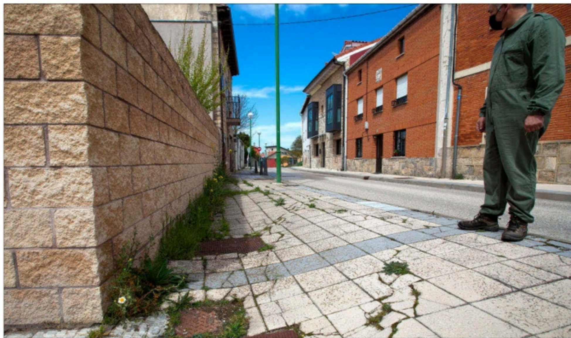
Grietas y hundimientos en una acera del barrio de Villatoro, en una imagen de archivo. TOMÁS ALONSO
